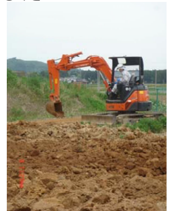
【重機を持ち込んだ作業】
